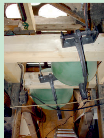
Cimbály na nové konstrukci ve věži vedle zvonů, v době montáže; Nahořany
